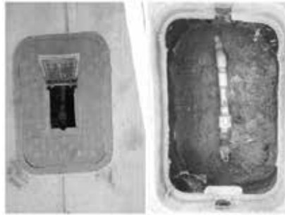
FIGURA 3. FALTA DE REGULARIZACIÓN DEL SERVICIO DE AGUA
