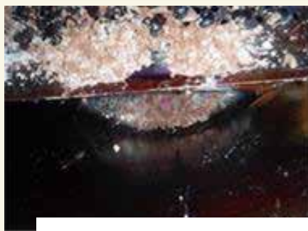
Interior de la columna C-056-01 antes del lavado
